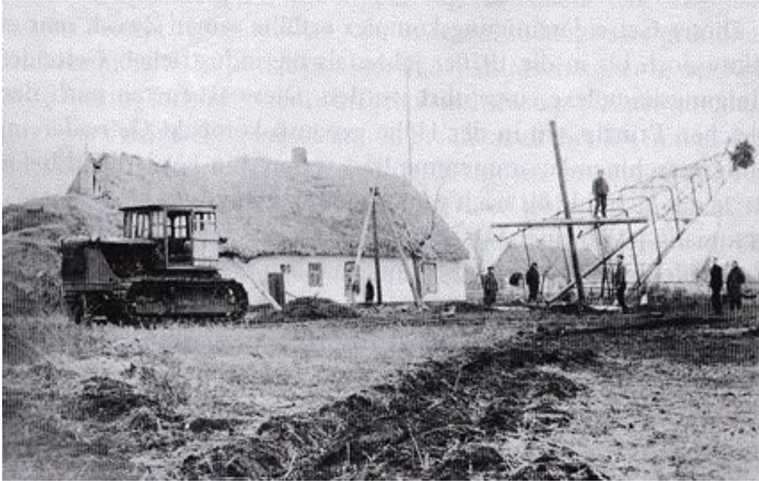
*Abb. 316: Der Turm für das Windrad wird aufgestellt.*
