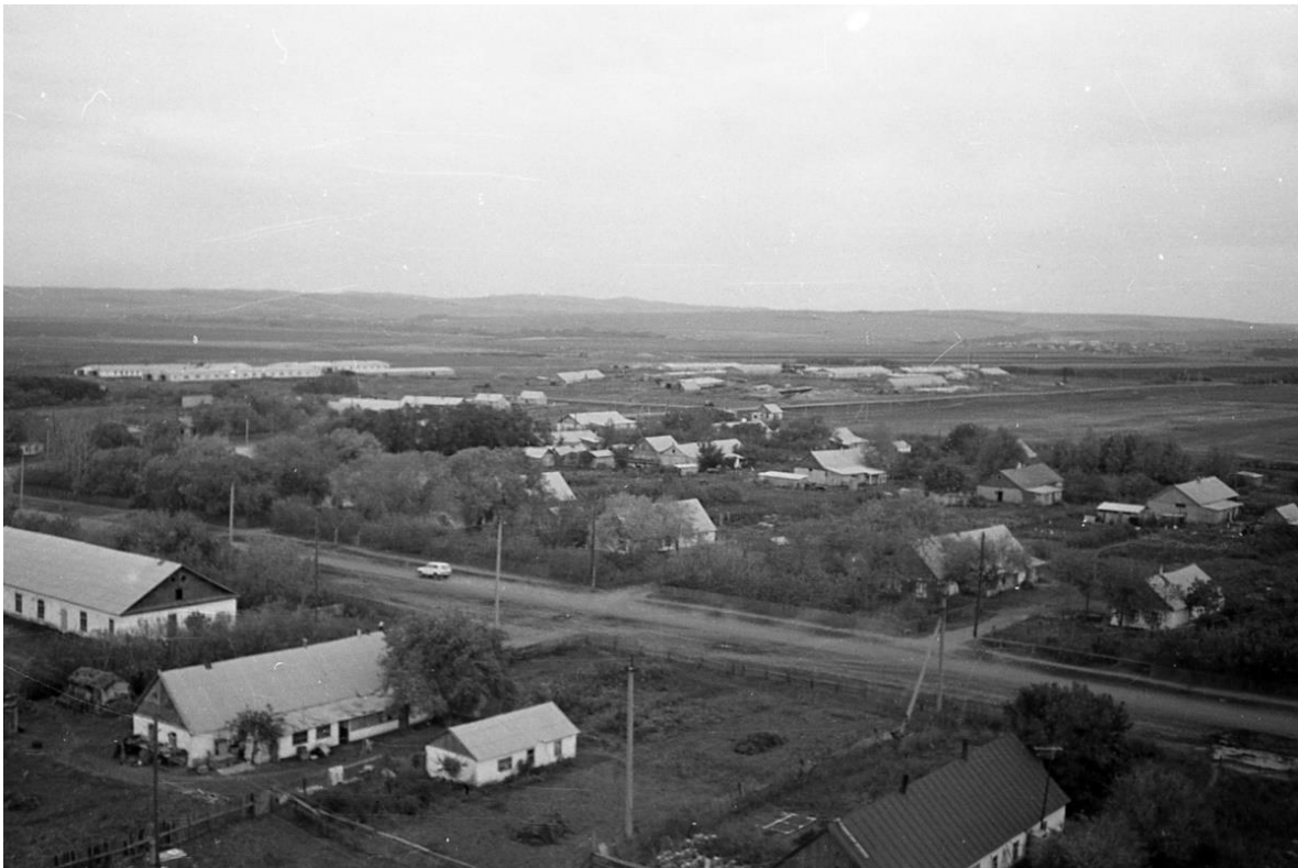
Vorne auf dem Bild ist das Haus mit der Sommerküche von Katharina Isaak zu sehen. Baujahr 1954. Früher stand hier die Erdhütte von den zwei Schwestern Unrau.
