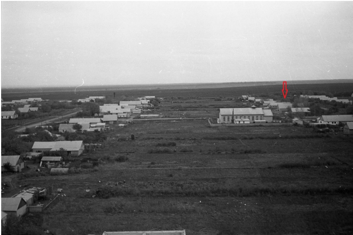
Der rote Pfeil zeigt auf das neue Haus von Abraham und Helene Klassen. Baujahr 1962
