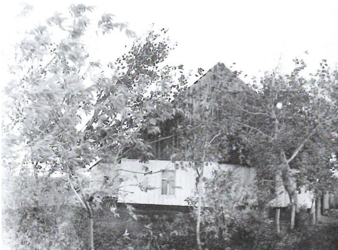
Das renovierte Haus nach dem Brand
