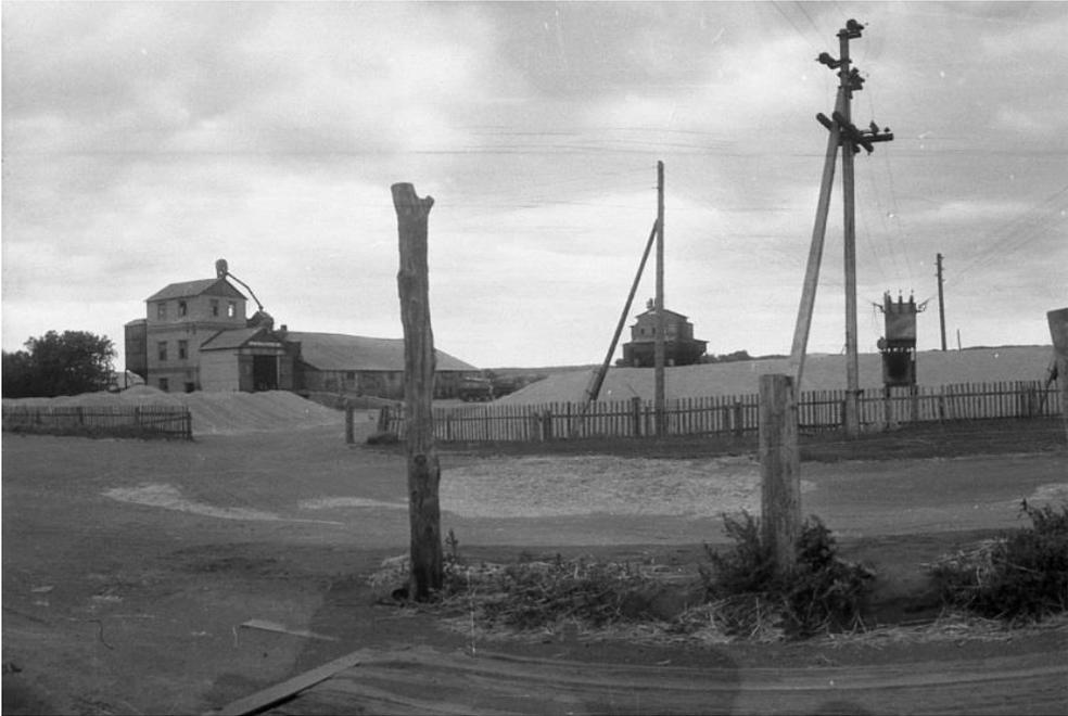
*Abb. 180: Das dreistöckige Haus auf der linken Seite und die Anlage rechts beherbergten die Getreidereinigungsanlagen. In der Mitte der Aufnahme steht der Getreidespeicher, auf dem Hof liegt das Getreide unter freiem Himmel.*
