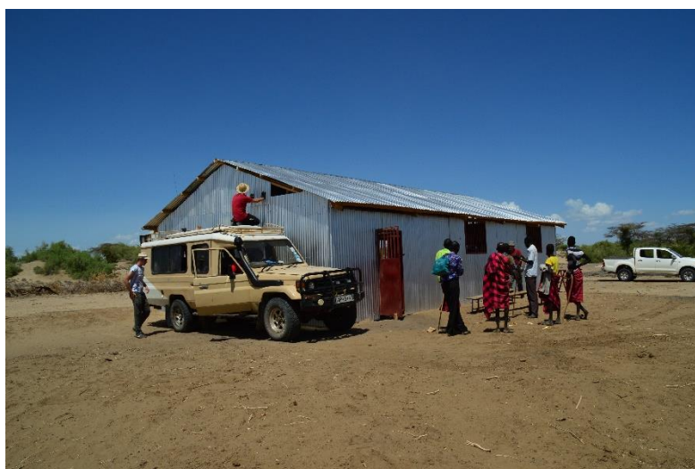
Abb. 78: Das fertiggestellte Bethaus.
