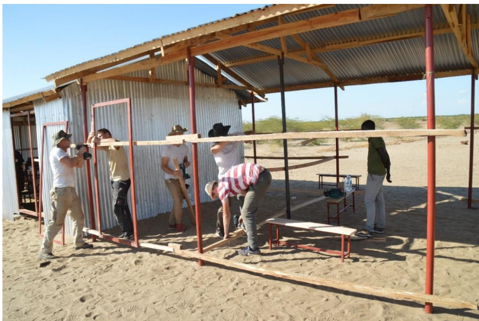
Abb. 94: Im Kindergarten wird für die Küche eine Trennwand gebaut.
