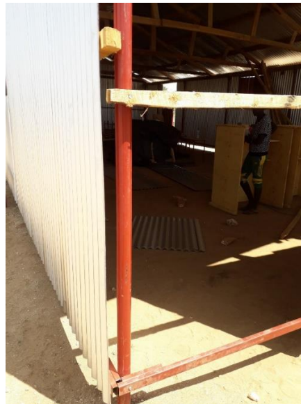
Abb. 71: Die unterste Befestigung musste wegen der Termiten aus Metall gemacht werden.
