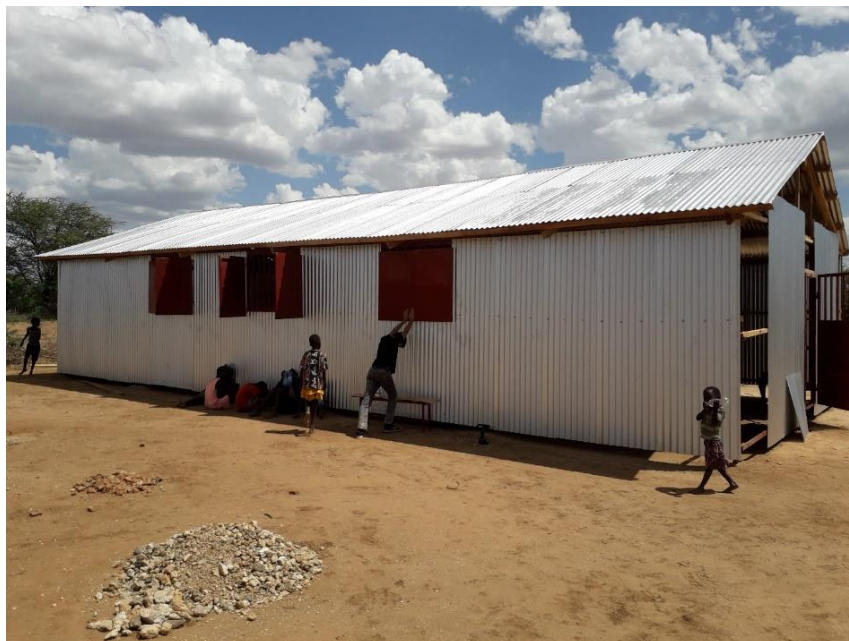
Abb. 72: Das Bethaus in Katilu bekommt klappbare Fensterläden.
