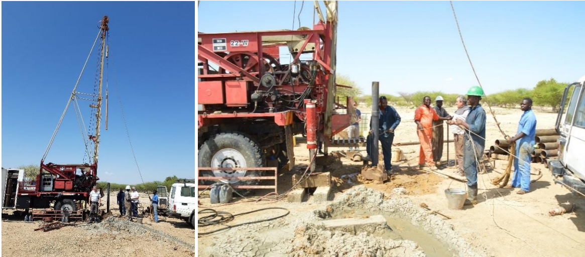
Abb. 51: Die Wasserader befindet sich hier in ca. 60 Metern Tiefe.
