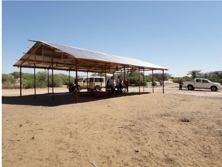
Abb. 76: Der Rohbau des Bethauses in Katilu A.
