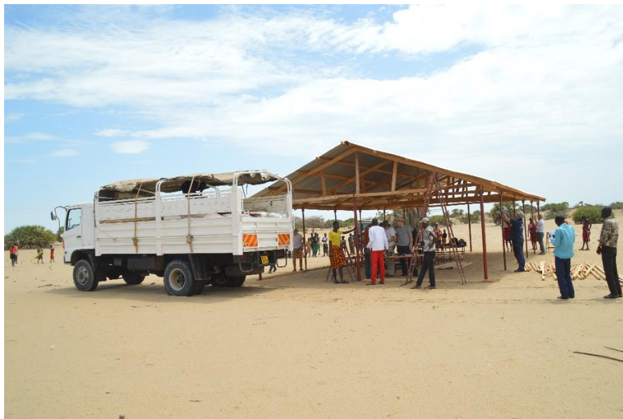
Abb. 38: Nach dem Abladen des LKWs geht die Arbeit gleich mit dem Verkleiden los.
