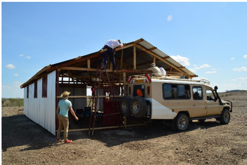
Abb. 60: Die Giebelarbeiten werden von dem Geländewagen aus erledigt.
