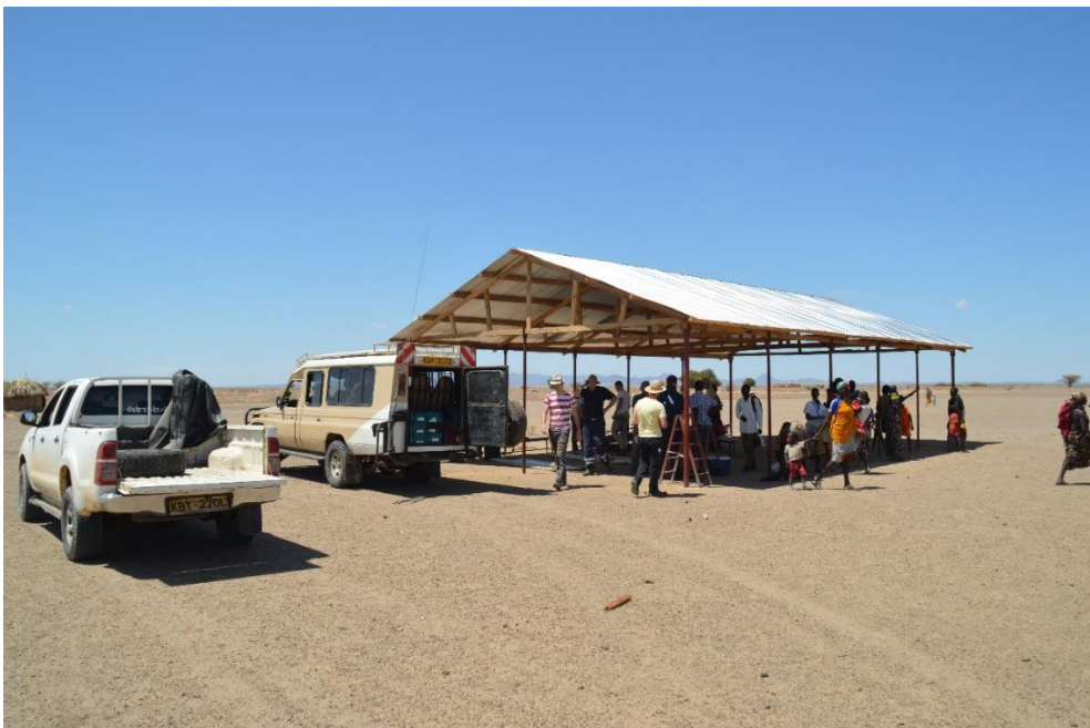
Abb. 85: Die Bethausbaustelle in Peikai.
