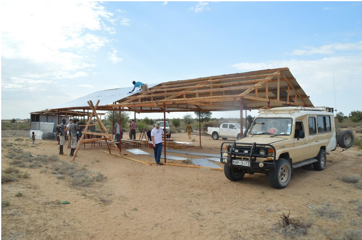
Abb. 105: Eine Baustelle in der Nähe der Stadt Lodwar.
