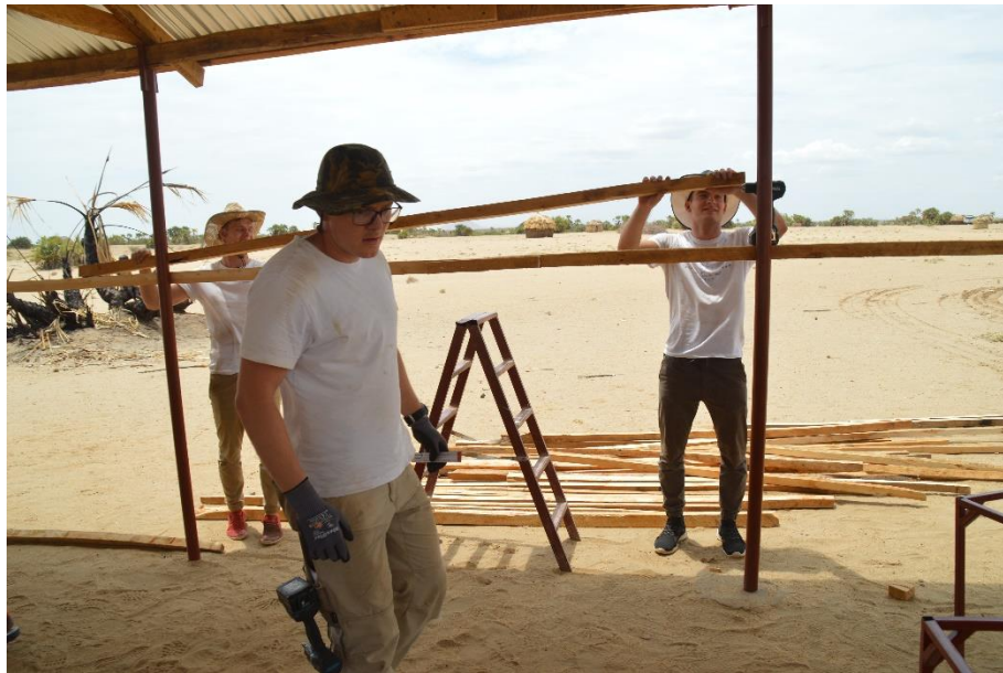
Abb. 39: Die Brüder schrauben die Latten an die Pfosten fest.
