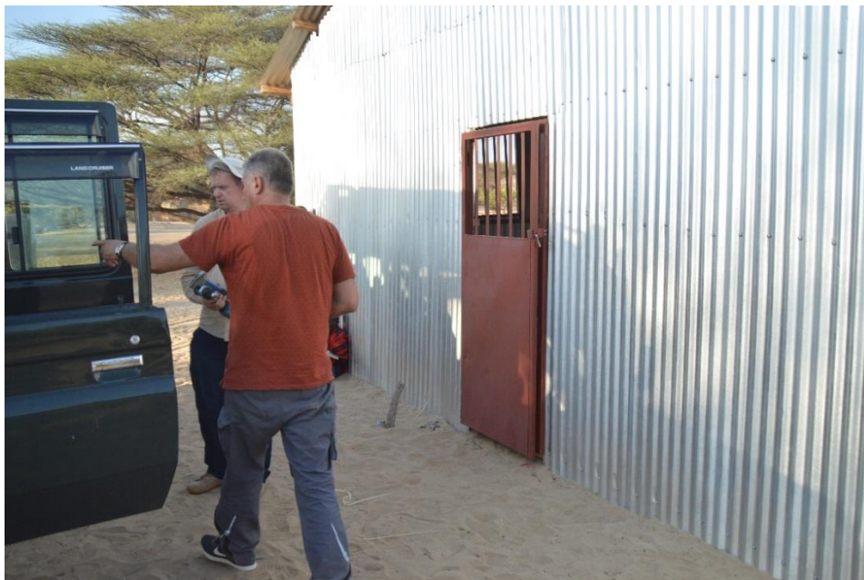
Abb. 42: Markus Nissen und Johannes Esau reparieren die Tür am Bethaus.
