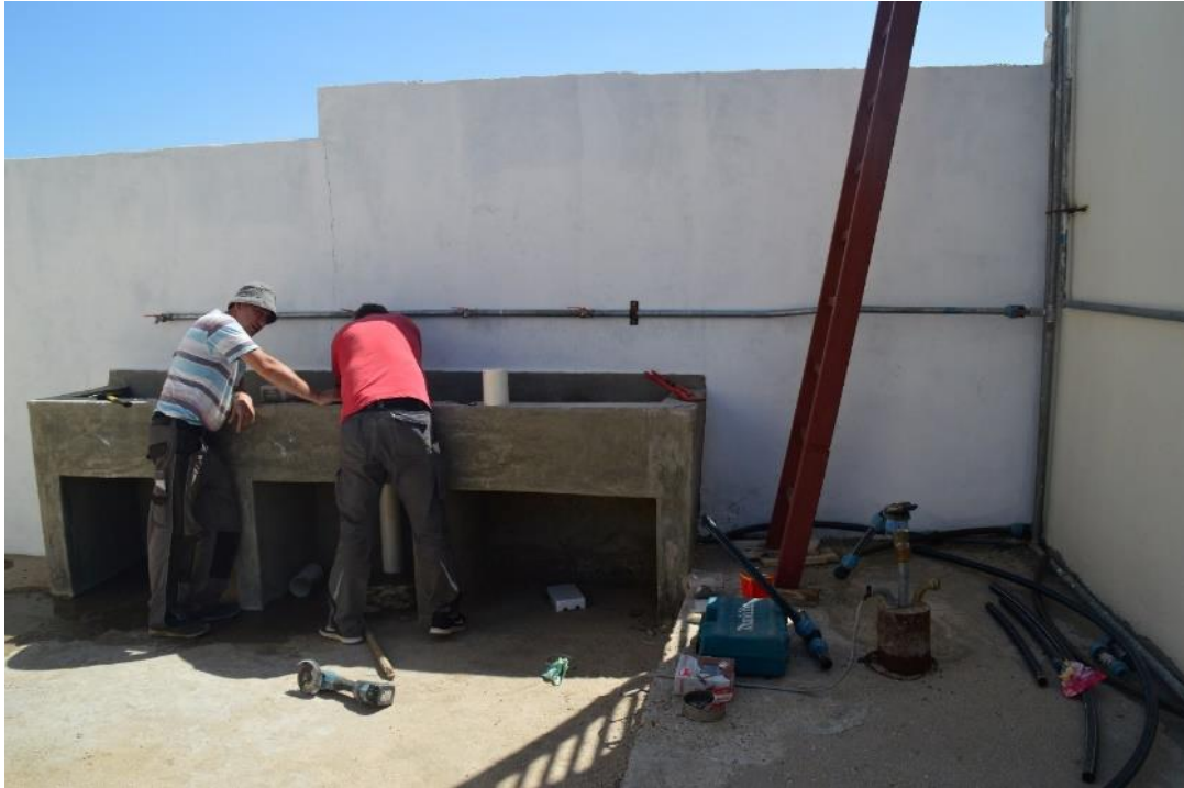
Abb. 100: Valeri Bitner und Johannes Esau installieren ein Waschbecken für draußen.
