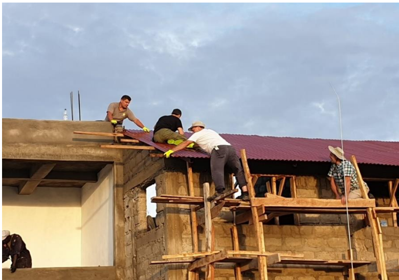
Auf den Platten des Dachstuhls werden Dachlatten und das Wellblech festgeschraubt.
