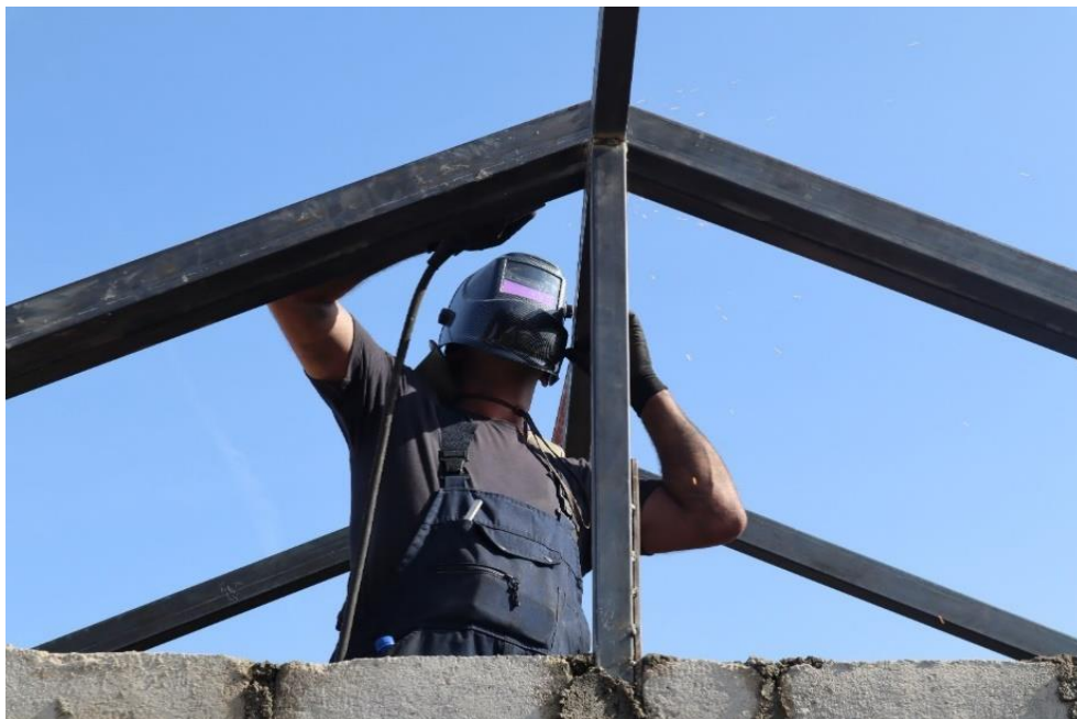
Die Dachstuhlkonstruktion wird verschweißt.
