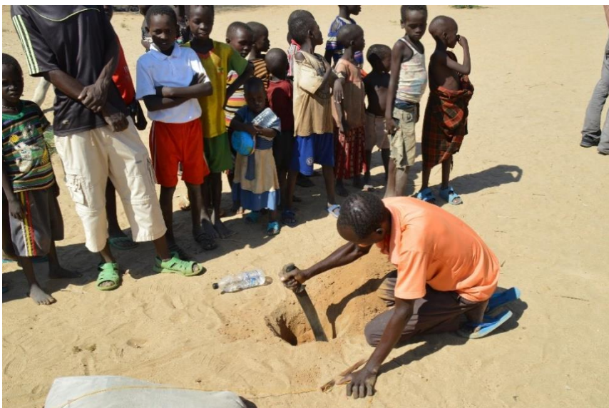
Die Löcher für die Metallständer wurden mit einem Buschmesser gegraben.
