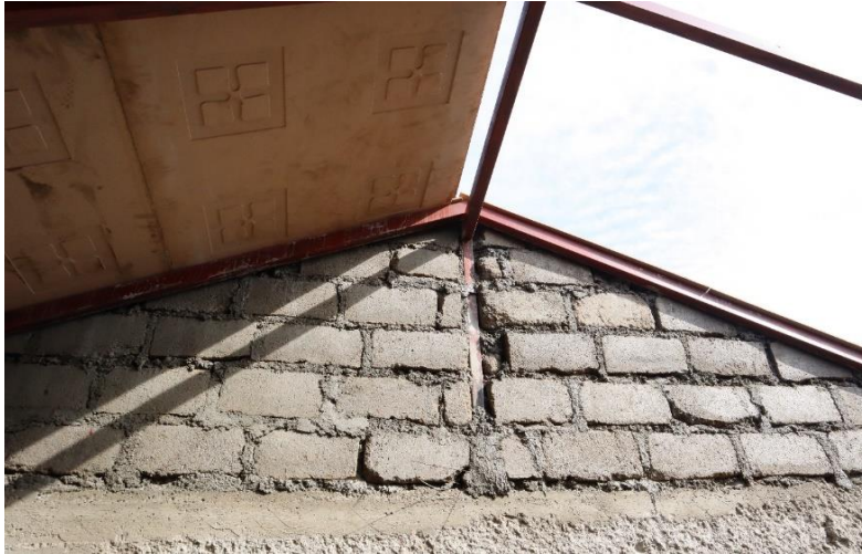
Auf dem Dachstuhl werden die Platten montiert.
