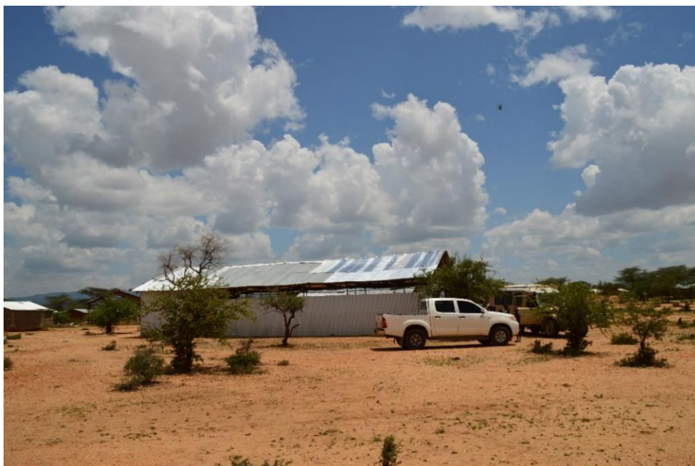
Das zuvor aufgerissene Dach vom Bethaus ist neu eingedeckt worden.
