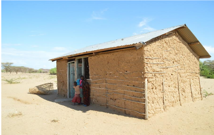
Das bisherige Schulgebäude in Nangolekuruk.
