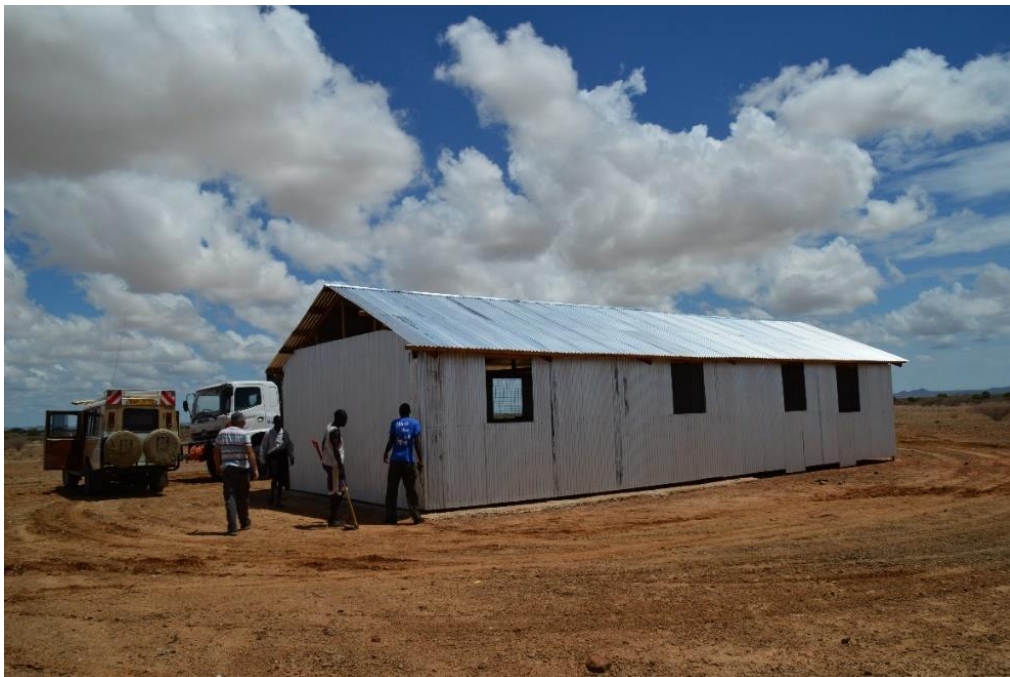
Das zweiklassige Schulgebäude in Lowoi-Egole.
