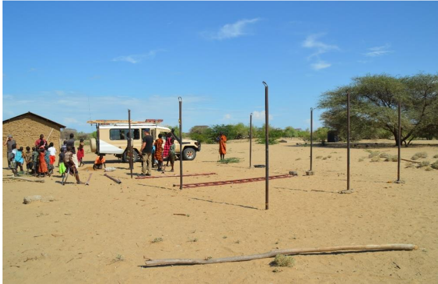
Das Metallständerwerk des Neubaus für die Schule.
