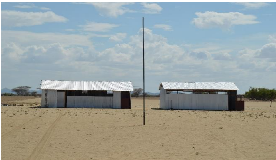
Das linke Schulgebäude wurde am 17.10.2019 fertiggestellt und das rechte Gebäude am 16.10.2019.
