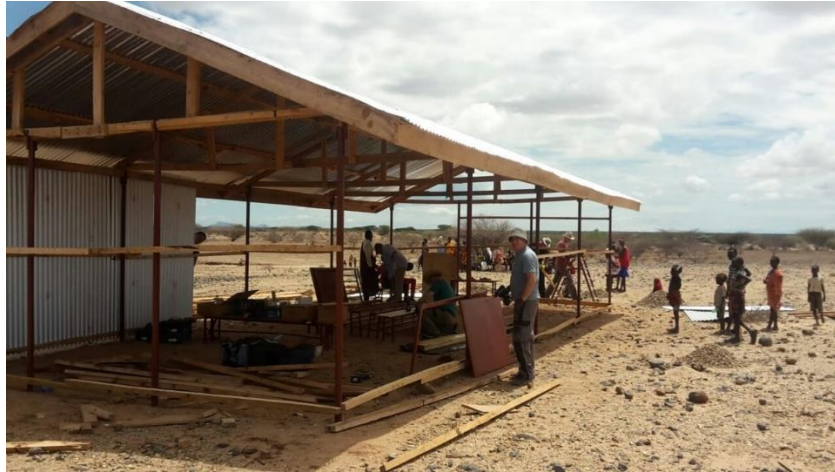
Die Baustelle des Bethauses in Moru-Arot.
