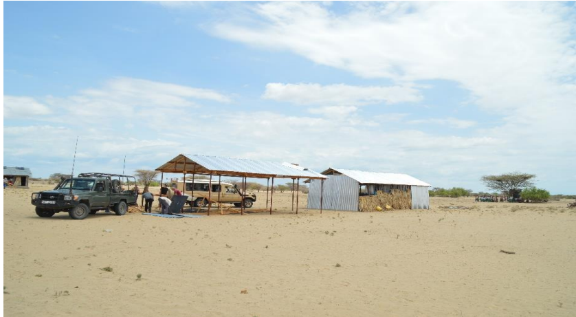
Auf der linken Seite ist im Hintergrund das Schulgebäude aus Stein zu sehen. Rechts davon steht das zweite Gebäude und in der Mitte befindet sich der Neubau, den wir verkleiden sollten.
