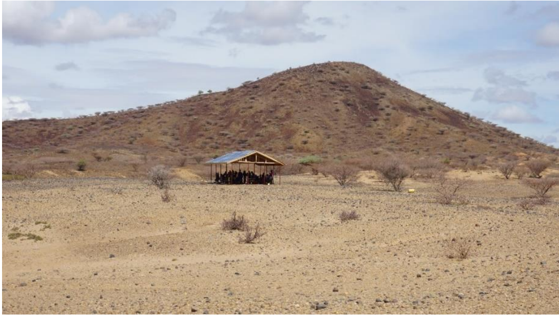
In der Einöde steht die Baustelle des Bethauses in Moru-Arot.
