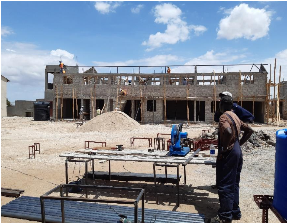
Es wird mit dem Aufstellen des Dachstuhls begonnen.
