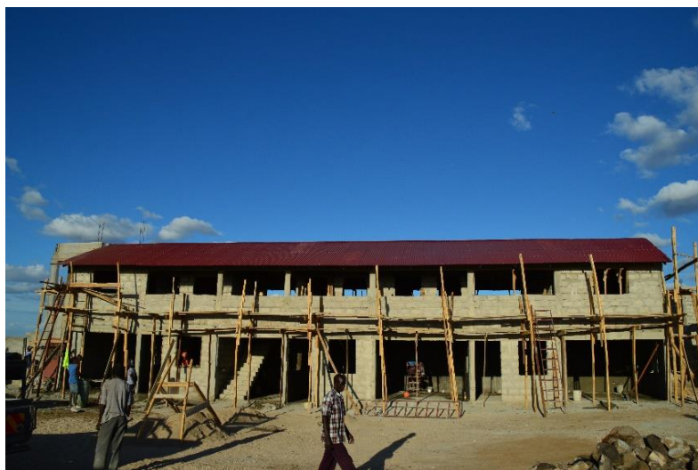
Der Dachstuhl und das Dach sind fertiggestellt.
