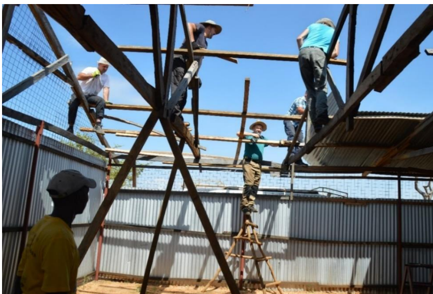
Der Dachstuhl wird verlattet und mit Wellblech neu gedeckt.
