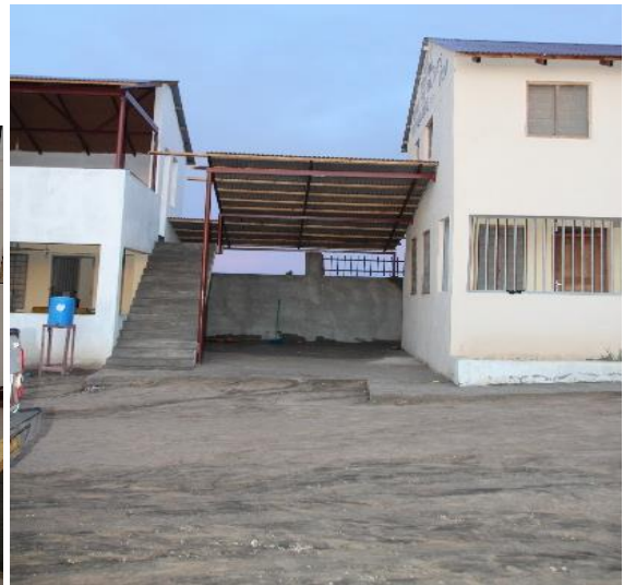
Das Zwischendach ist fertiggestellt.
