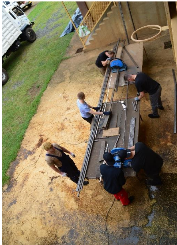
Die Durchführung von Metallarbeiten.
