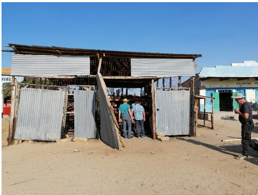
Unterwegs wurde Holz für das kaputte Bethausdach in einem Holzhandel eingekauft.
