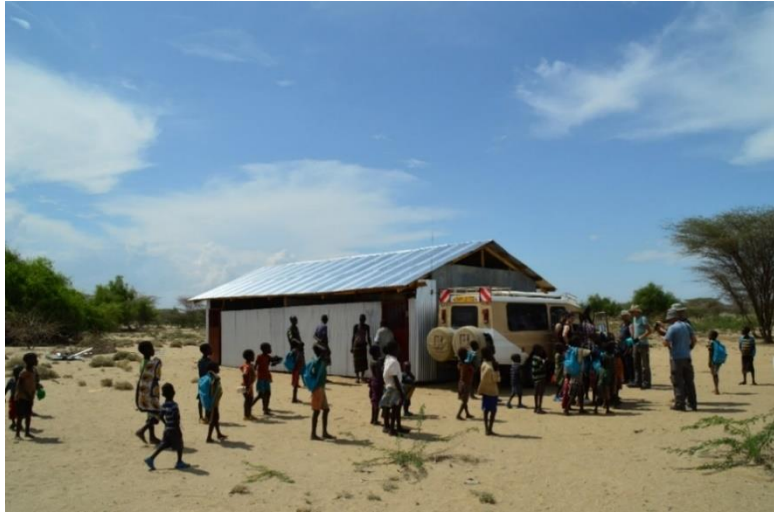
Der Neubau der Schule in Nangolekuruk.
