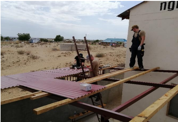
Auf den Dachlatten wird das Wellblech verschraubt.
