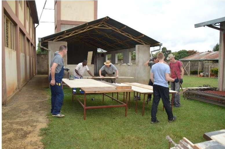
Die Fertigung von Holzarbeiten.
