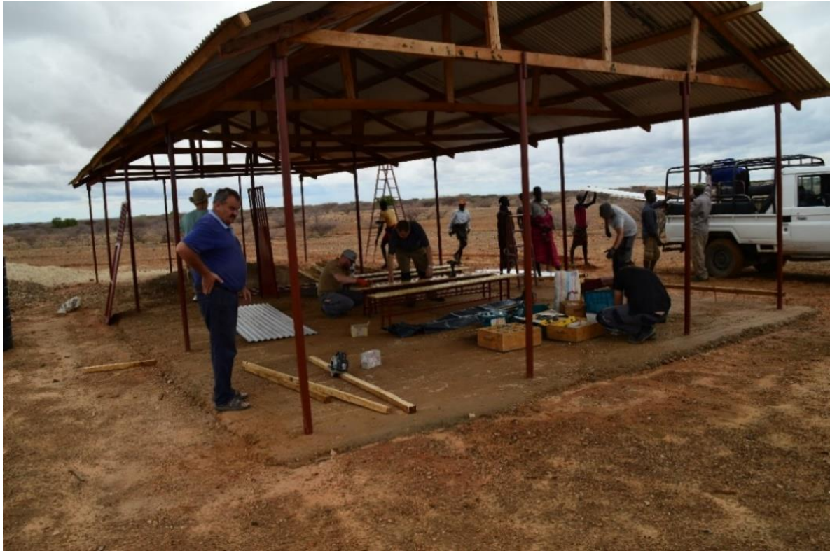
Der Rohbau der zweiklassigen Schule in Lowoi-Egole.
