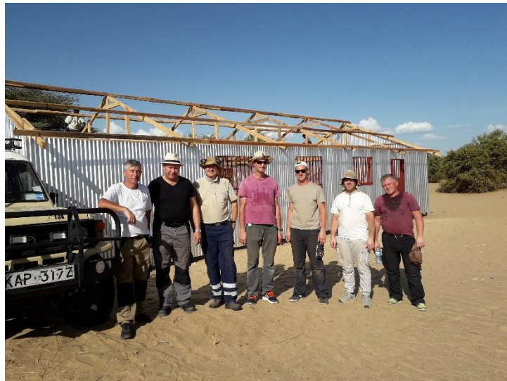
Die Brüder aus der Baugruppe.
