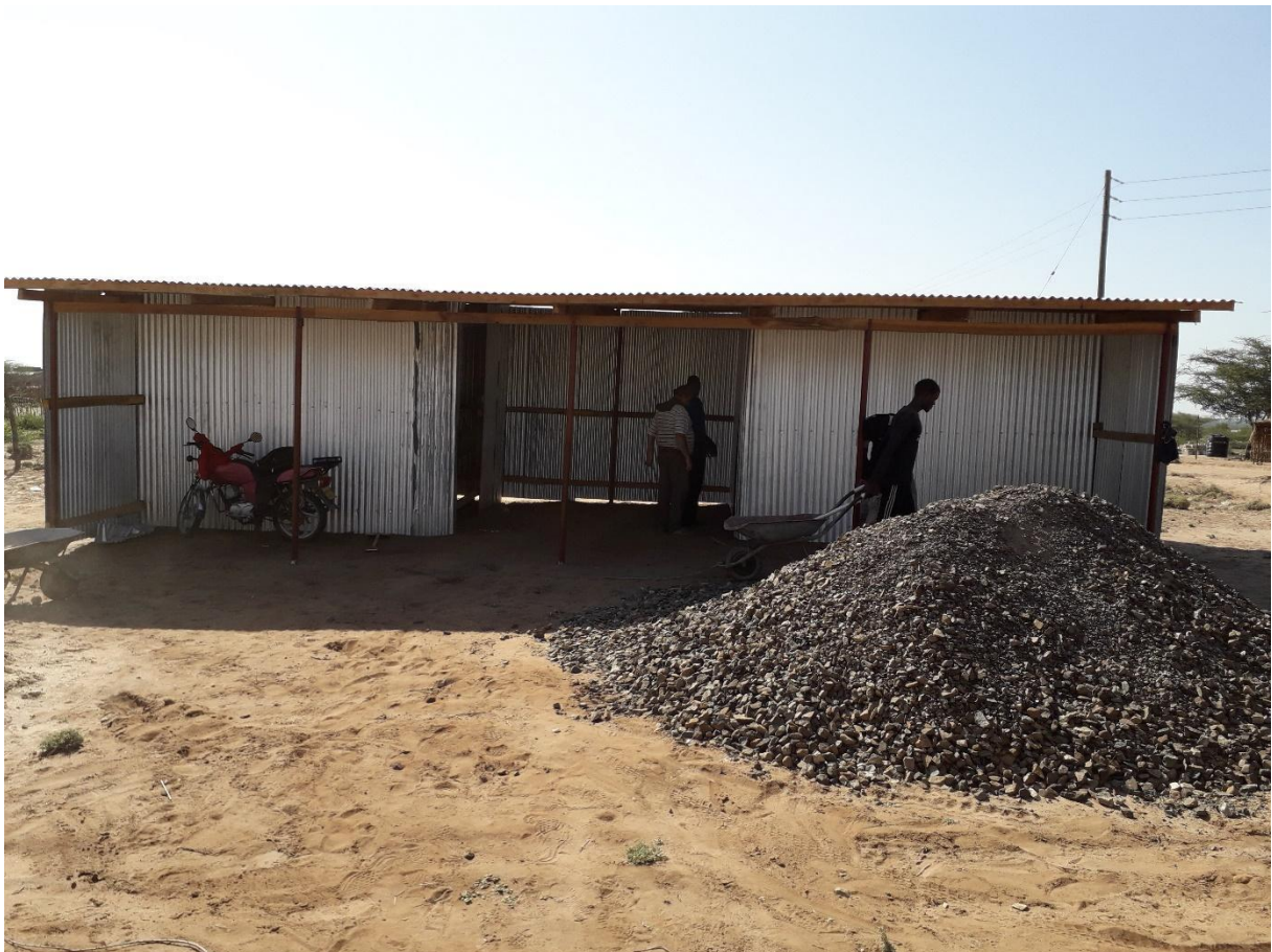
Baustelle in Lokaparaparaí. Baujahr 2021
