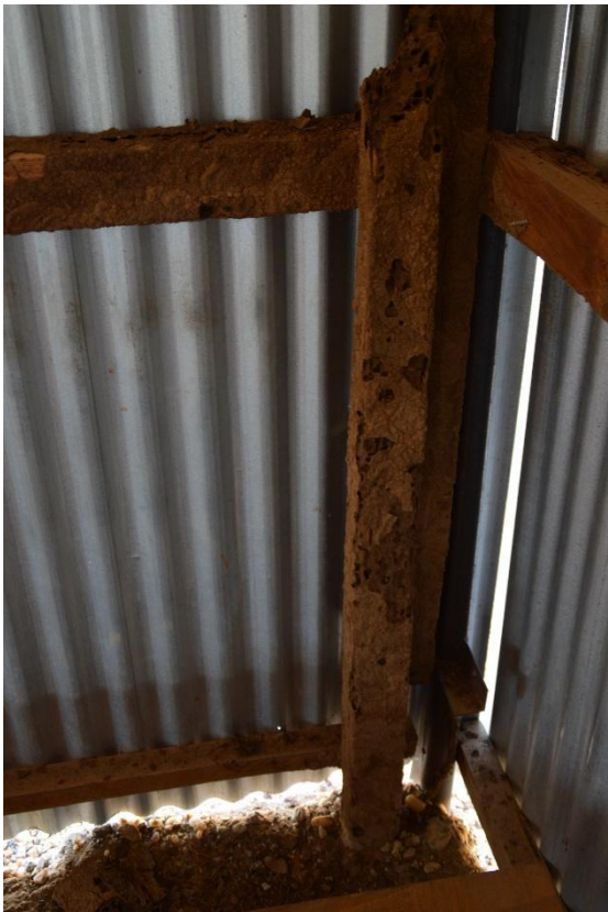
Die Termiten haben in Bethaus die Holzkonstruktion zerstört.
