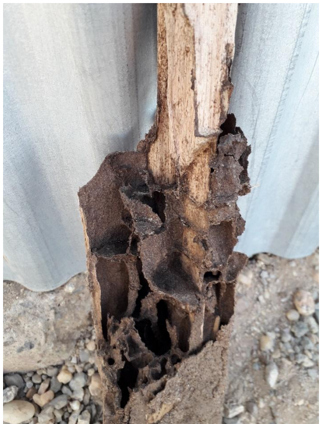
Die Termiten haben in Bethaus die Holzkonstruktion zerstört.
