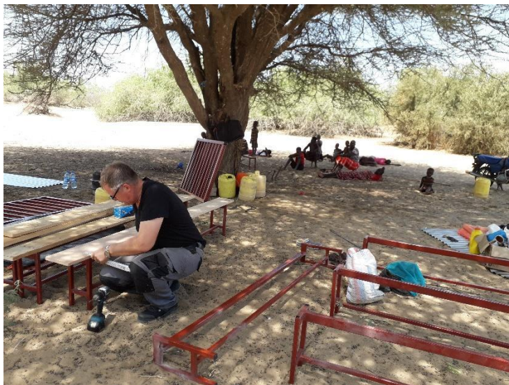
Peter Janzen baut unter einem Baum eine Kanzel und 14 Bänke zusammen.
