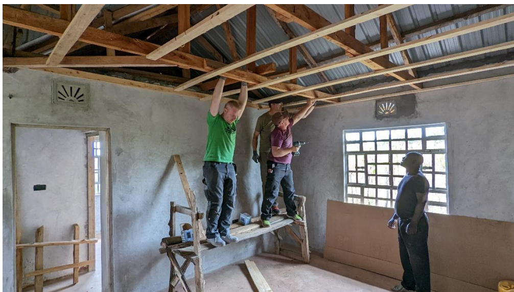
Hier wurden die Zimmerdecken verkleidet.
