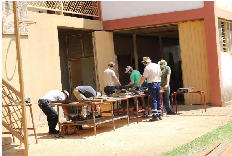
Vorbereitungen für den Zuschnitt von Metallstücken.
