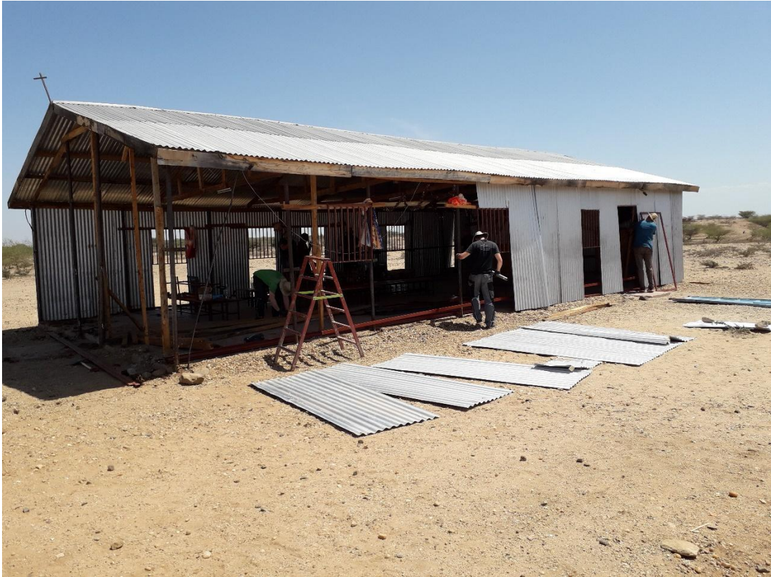
Das Wellblech wird während der Renovierung abmontiert und später wieder dran geschraubt.
