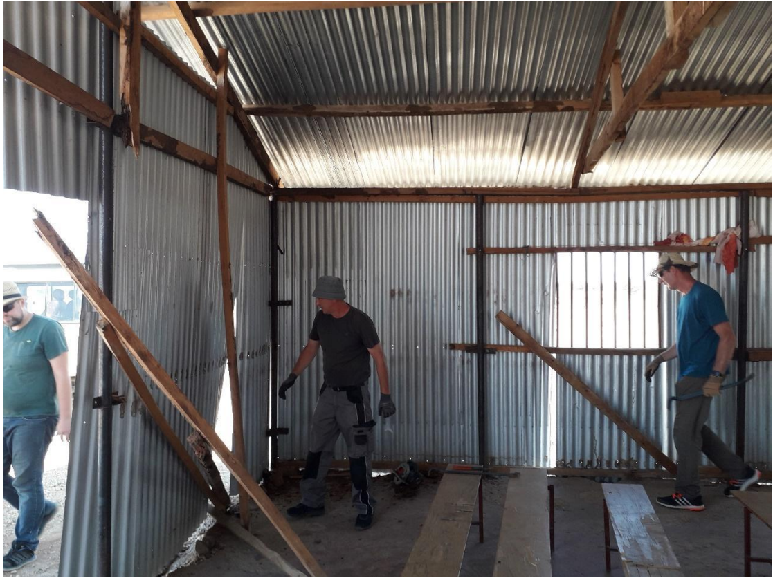
Die zerstörten Holzplatten werden entfernt und durch Metallvierkantrohre ersetzt.
