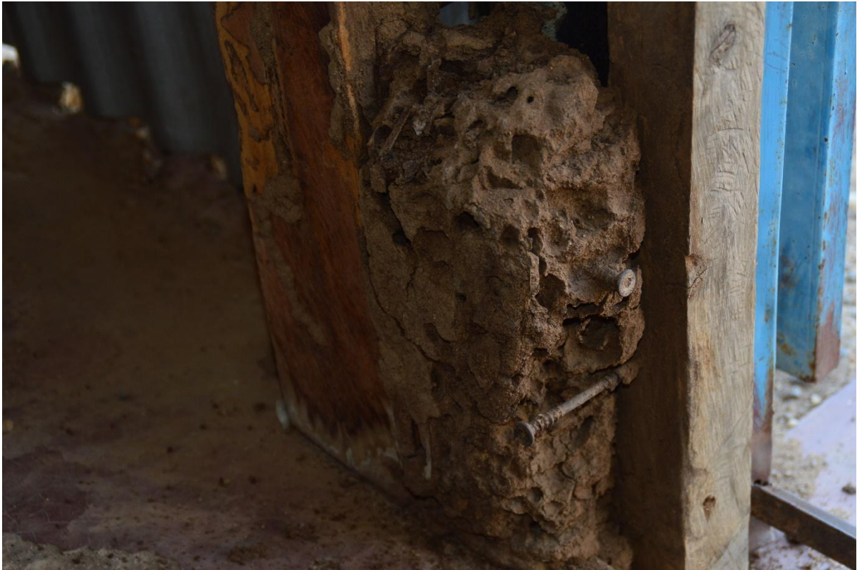
Die Termiten haben in Bethaus die Holzkonstruktion zerstört.
