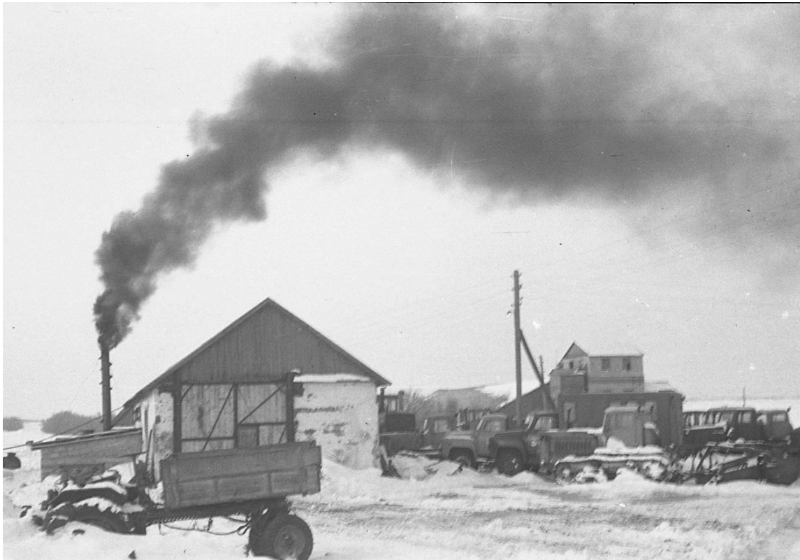
Die beheizbare Traktoren Garage.
