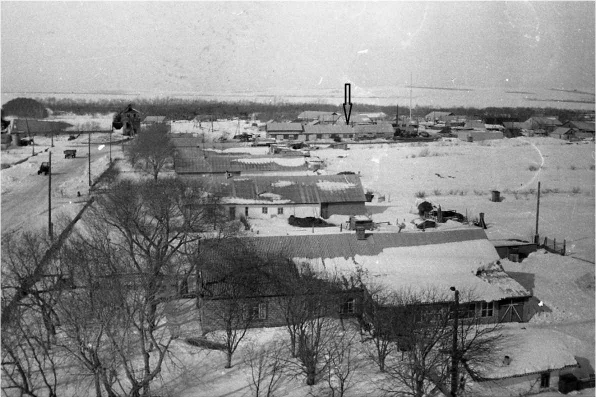
Der Pfeil zeigt auf das Schmiede-Garage-Ölpresse Gebäude.
