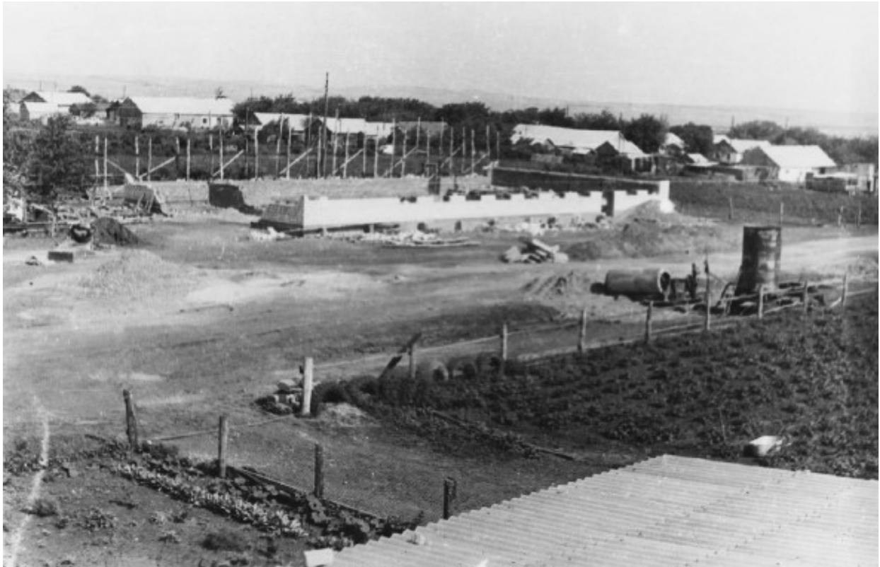
Ende der dritten Bauwoche. Die Wände stehen bis auf Fensterhöhe.
