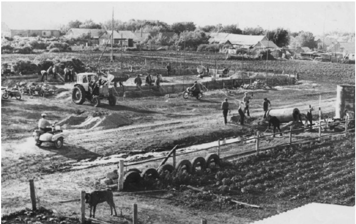
Eine Verschalung für den Sockel des Fundaments wird aufgebaut. Sofort hinterher wird der Beton gegossen. Gleichzeitig wäscht eine andere Brigade die ganze Zeit den Schotter.
