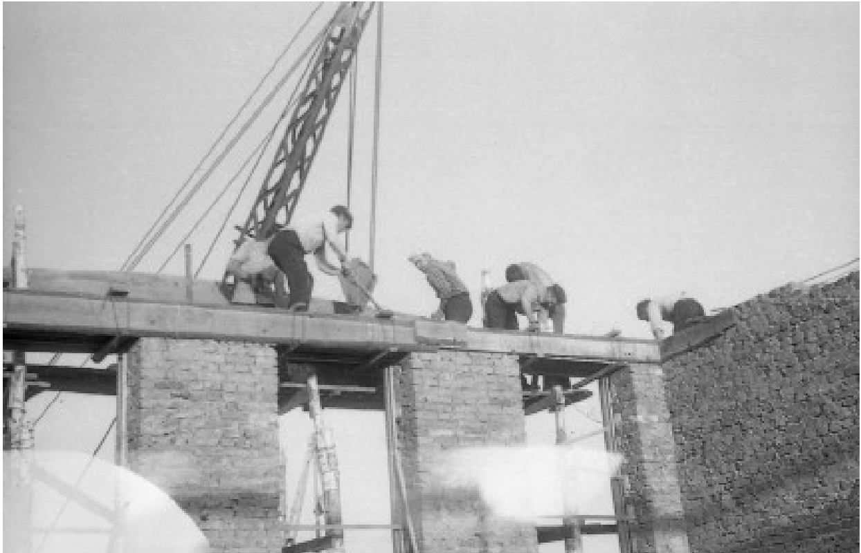
Gießen der Betongurtung über den Fenstern. Johann Töws bediente uns mit einem Kran.
