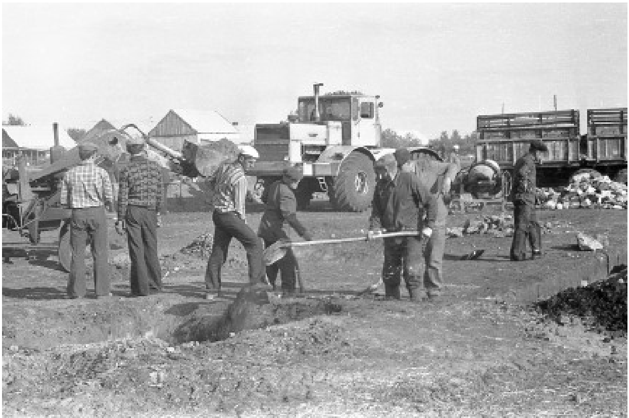
Ausgehobene Erde wird weggefahren, gleichzeitig werden Steine und Schotter angeliefert
