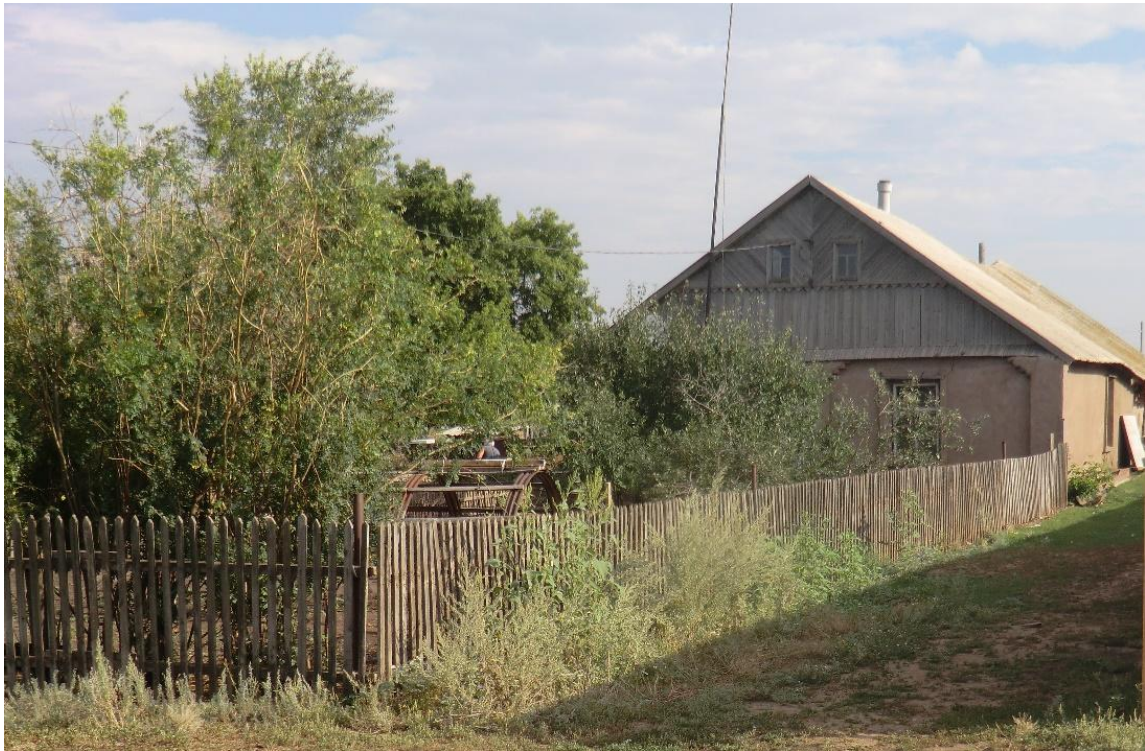
Das Haus von Heinrich und Margarete Wiebe. Am Haus wurden einige Male Renovierungen am Dach und Fassade vorgenommen. Fotoaufnahme 11.08.2014
